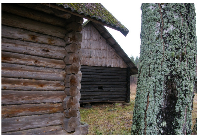
Foto 58. Näide pööningu puittarindi otsaseina viimistlustest.
