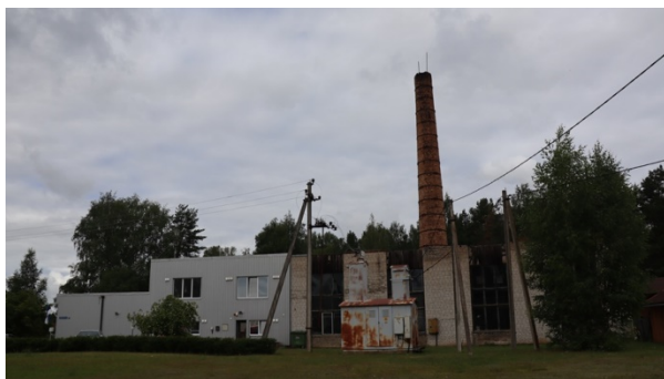
Foto 1. Värskas vana kaugküttekatlamaja
