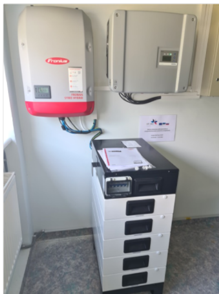
Foto 24. Obinitsa külakeskuse akupank koos inverteriga Fronius
