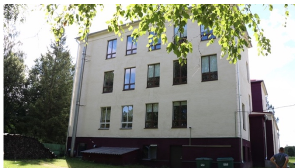
Foto 26. Koolihoone otsvaade korstnaga
