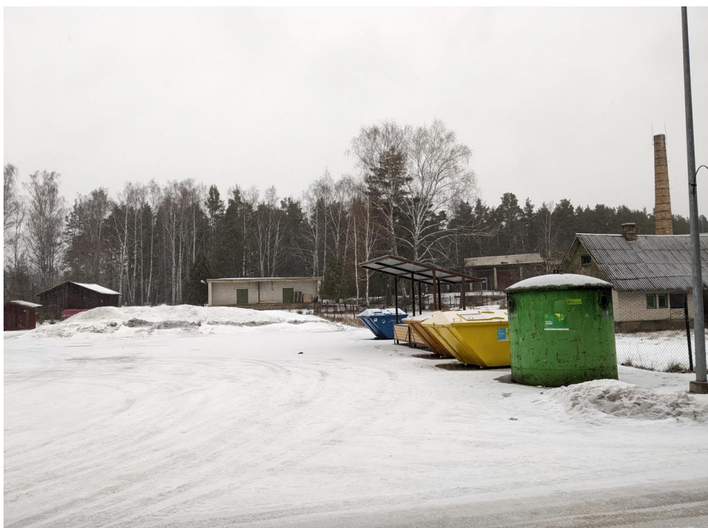
Foto 4. Olemasolev turuplats Järvesuu 4 kinnistul. Vaade lõunast.
